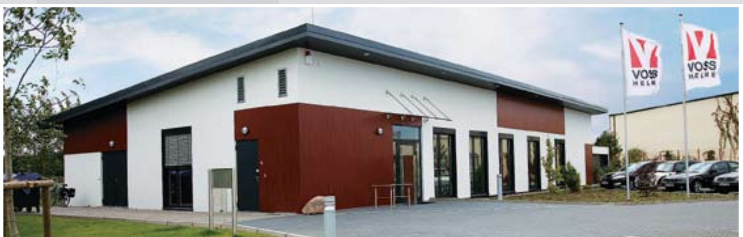
Onze kantoren – een modern plus-energiegebouw
